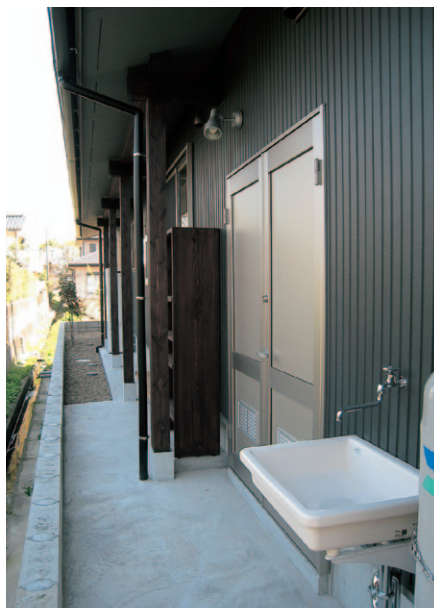
バックヤードはご主人の趣味である釣りを楽しむためのスペース。多目的に使う「趣味部屋」から外部へ出ると冷凍庫室があり、釣り道具も収納する。釣り道具を洗ったり、魚をさばく、外流しも設けた。
