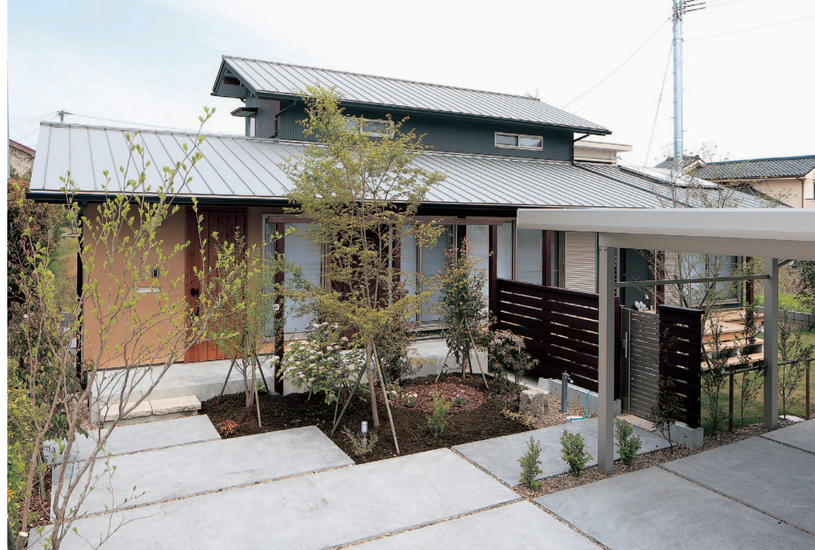
郊外に日当たりのよい広めの敷地を選択し、東西に延びる軒の出の深いシンプルな平面計画。通風・採光に有利な形状は、冬の陽射しを取り入れる窓開口も大きく取る
