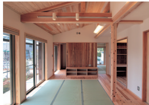
南側の大きな開口からの陽射しで冬はとて暖かい。深い軒の出と勾配天井の採用で、夏の遮熱、排熱がスムーズに行える計画だ。正面の板壁には、ご主人の故郷屋久島の地スギを使用
