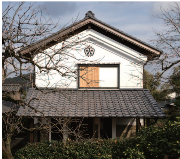
離れにある蔵。京都より取り寄せた漆喰で外壁を再生。屋根には太陽光発電が備わっている
