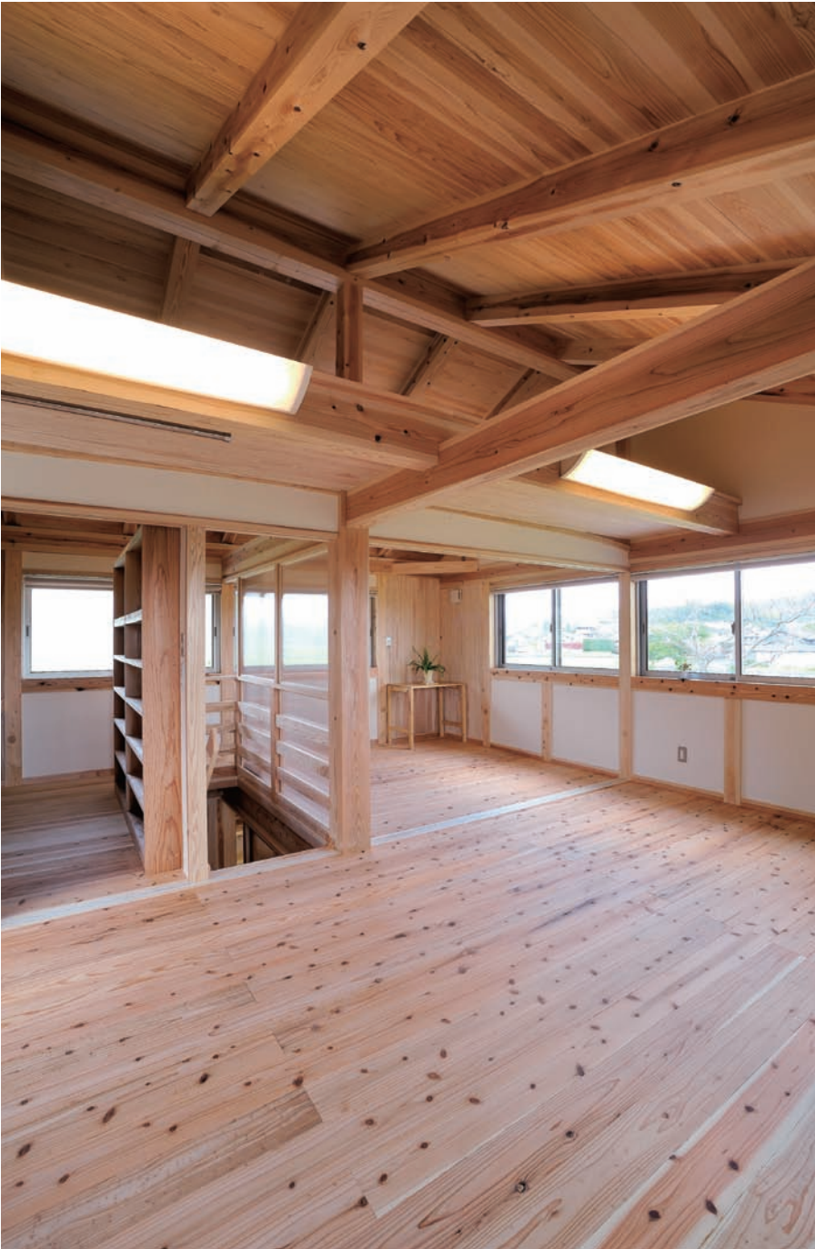
2階「田の字」ワンルーム。6mの長材を使い、部材や仕口の敷を抑え、仕上げを兼ねた杉パネルで構造強度を高めています
