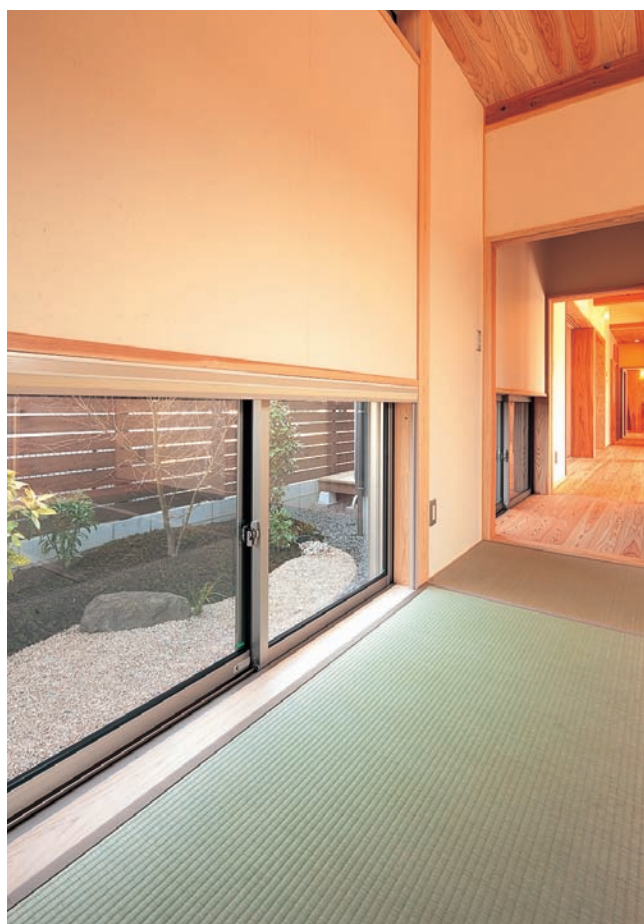
玄関横の和室。北面には住宅もあるため、地窓を使って採光・通風を確保。小さいながらも庭とウッドデッキを造り、目にも楽しいだけでなく、東西を抜ける風の有効利用も狙っている。すべての窓にハニカムサーモスクリーンを使い、断熱効果をアップ
