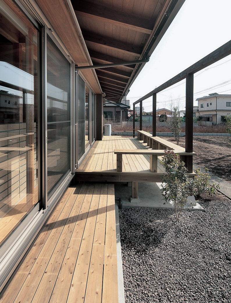
南面をつなげるウッドデッキは、深い軒にベンチもあり、気持ちよく過ごせる空間。庇とフレームにヨシズをかけて日除けにしたり、幕を張れば東西の風を室内へ取り入れることもできる
